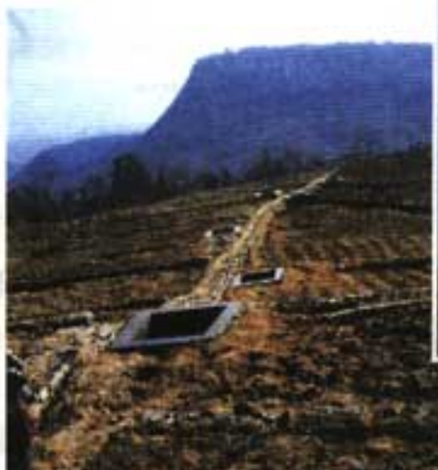
图5-12 干旱地区的集雨井
