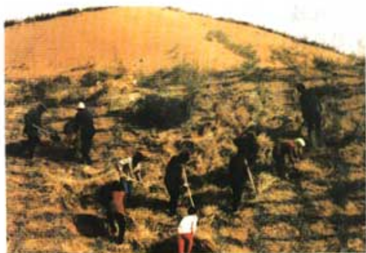
图 5-8 草方格阻止沙丘移动
