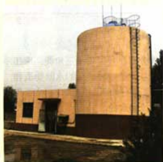
大型沼气池外观（北京大兴区留民营村）
